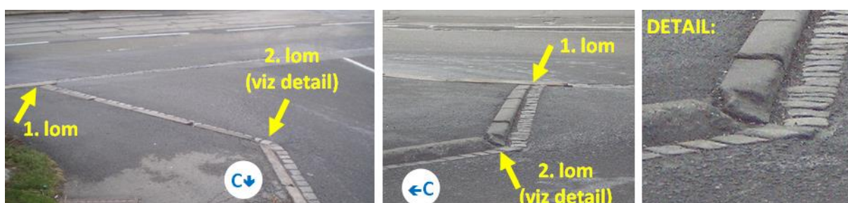
Obr. 4 – Nároží č. 1 (s detailem poškozeného obrubníku)
