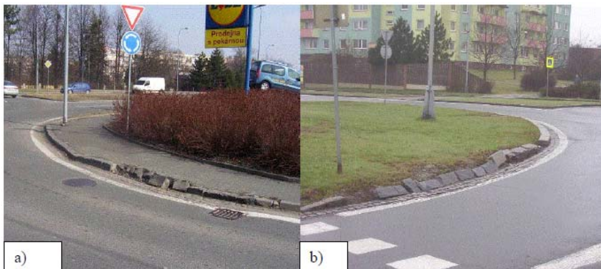
Obr. 10 - Porušení nároží na vjezdu (a) a výjezdu (b)
