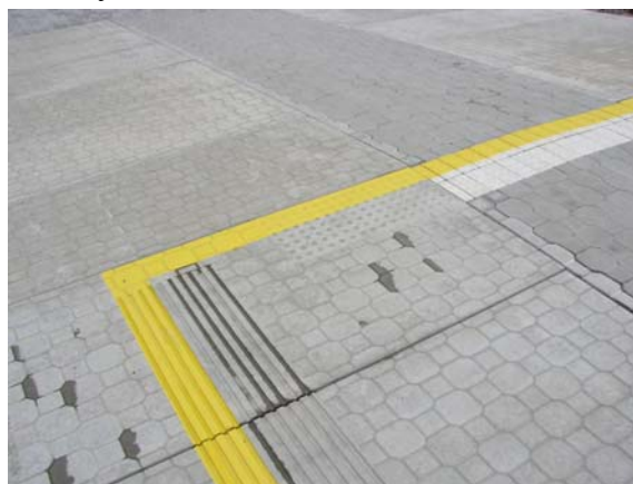
Obr. 2 - Barevně a hmatně kontrastní úpravy povrchu železničního ostrovního nástupiště
