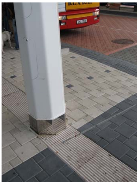
Obr. 3 - Vodící linie na nástupním ostrůvku (sloup měl být usazen mimo)
