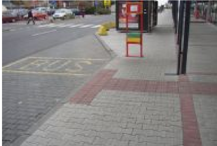
Bild 1: Lebensgefährliche Gestaltung für Sehbehinderte - die Leitlinie führt in den Raum für Verkehrsmittel (Avion Park Praha, Herbst 2005)
