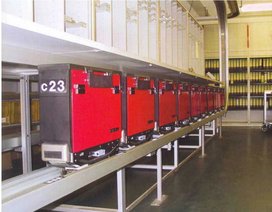
Obr. 3: Kontejner systému Unicar
