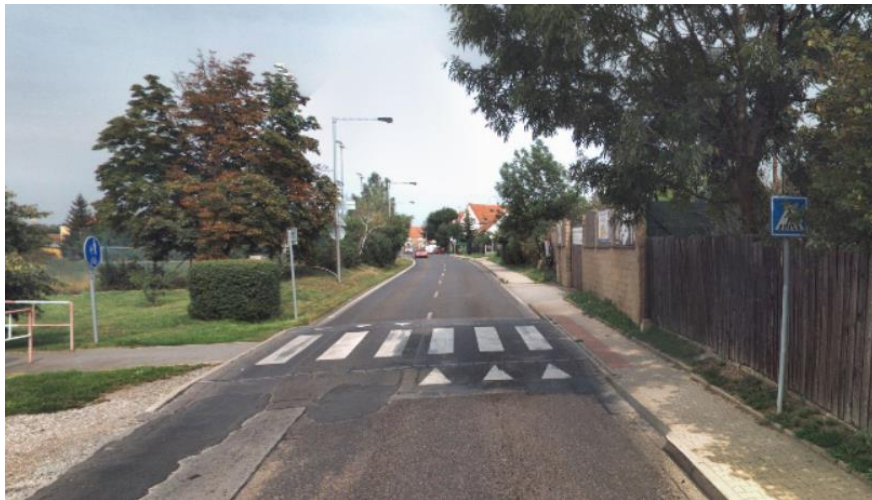
Obr. 3 Dlouhý příčný práh, ul. K Hrnčířům; zdroj: Mapy.cz
