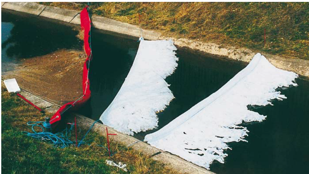
Obr. 3 – Čistenie toku hydrofóbnym sorbčným prostriedkom
