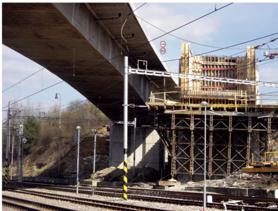
Obr. 1 - Príklad obmedzujúceho prvku prevádzky ŽI z dôvodu stavebných prác v obvode dráhy – diaľnica D3 Hričovské Podhradie – Kysucké Nové Mesto
