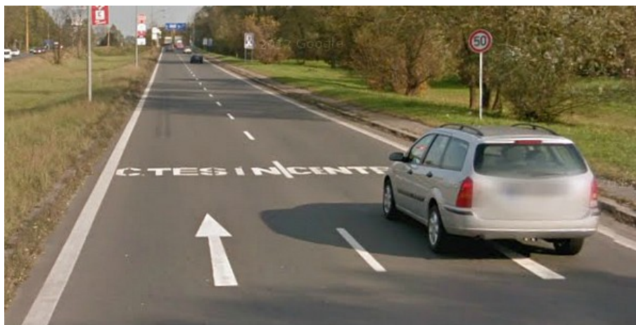
Obr. 7 – Orientační vodorovné značení před okružní křižovatkou
