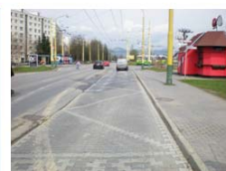
Obr. P34 Celkový pohľad na zastávku
