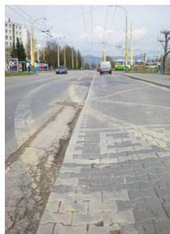
Obr. P35 Styk asfaltového a dlažbového krytu
