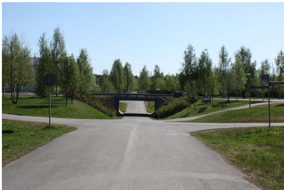
Obr. 5 - Ukázka mimoúrovňového křížení cyklostezky s pozemní komunikací
