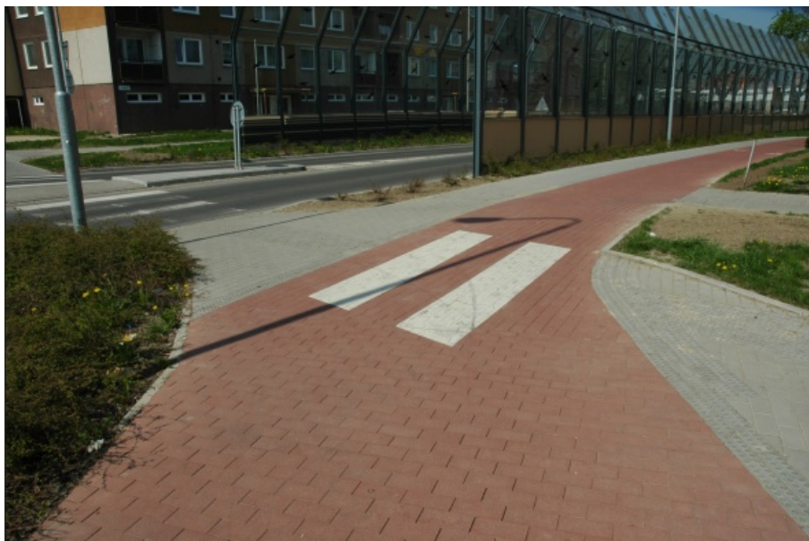
Obr. 16 - Příklad křížení cyklostezky s chodníkem
