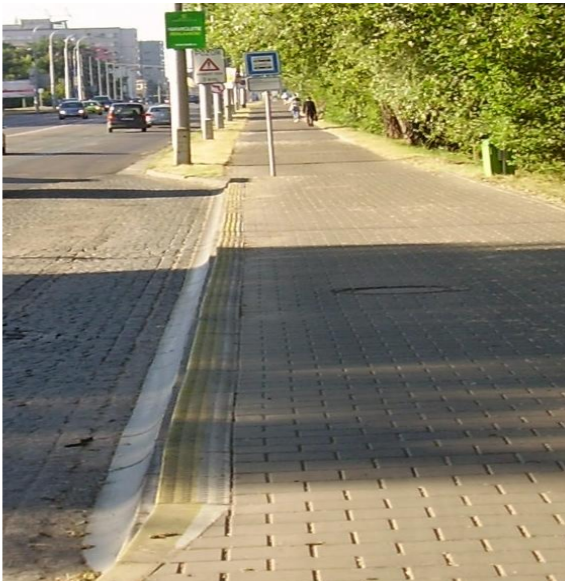
Obr. 4 - Sdružená zastávka MHD v Pardubicích Stavařov, mimo jízdní pruh bez fyzického oddělení (v zálivu) – Typ II s úpravou nástupní plochy
