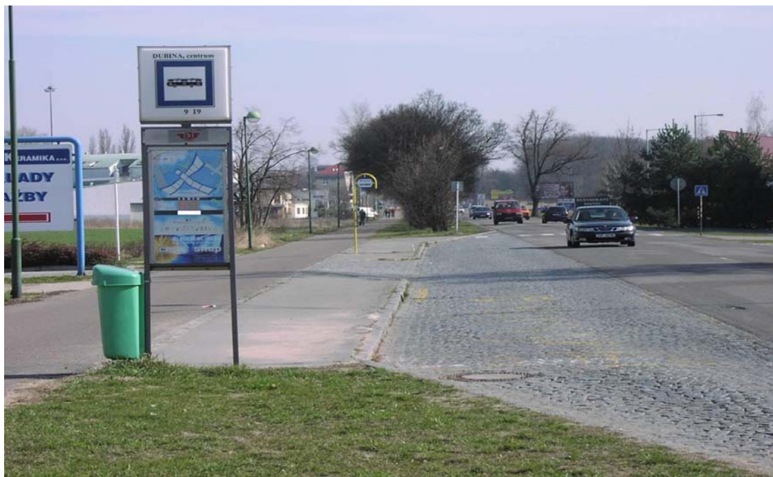
Obr. 2 - Autobusová zastávka Pardubice, Dubina (směr do Pardubic) mimo jízdní pruh bez fyzického oddělení – v zářezu - Typ II
